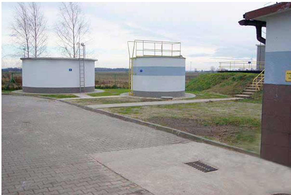
Oczyszczalnia ścieków w Czarnożyłach po rozbudowie i modernizacji
