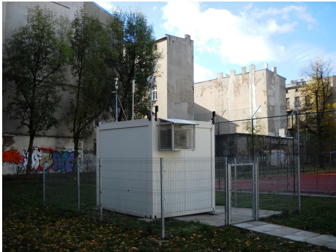
Automatyczna stacja pomiarów tła miejskiego w Łodzi przy ul. Gdańskiej
