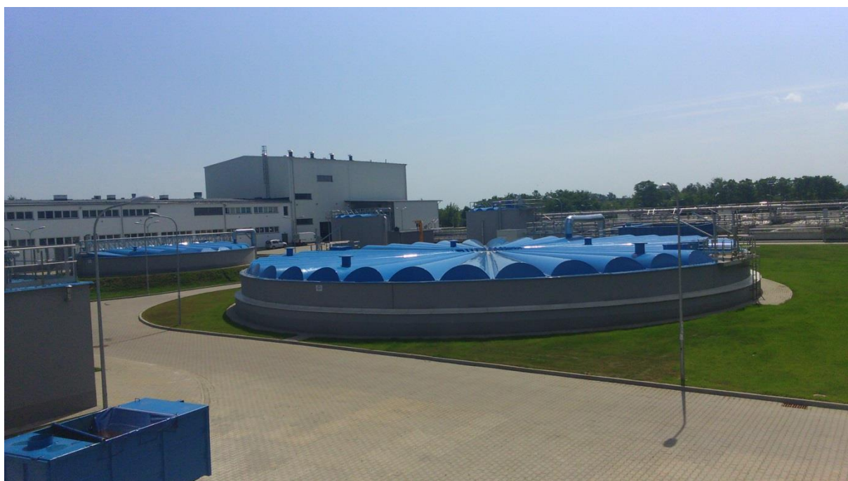
Oczyszczalnia ścieków w Tomaszowie Mazowieckim
