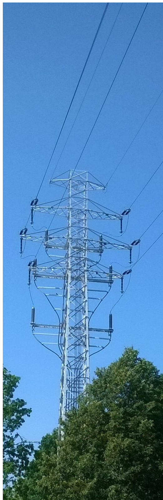
Stup wysokiego napięcia fot. A. Wachowiec
