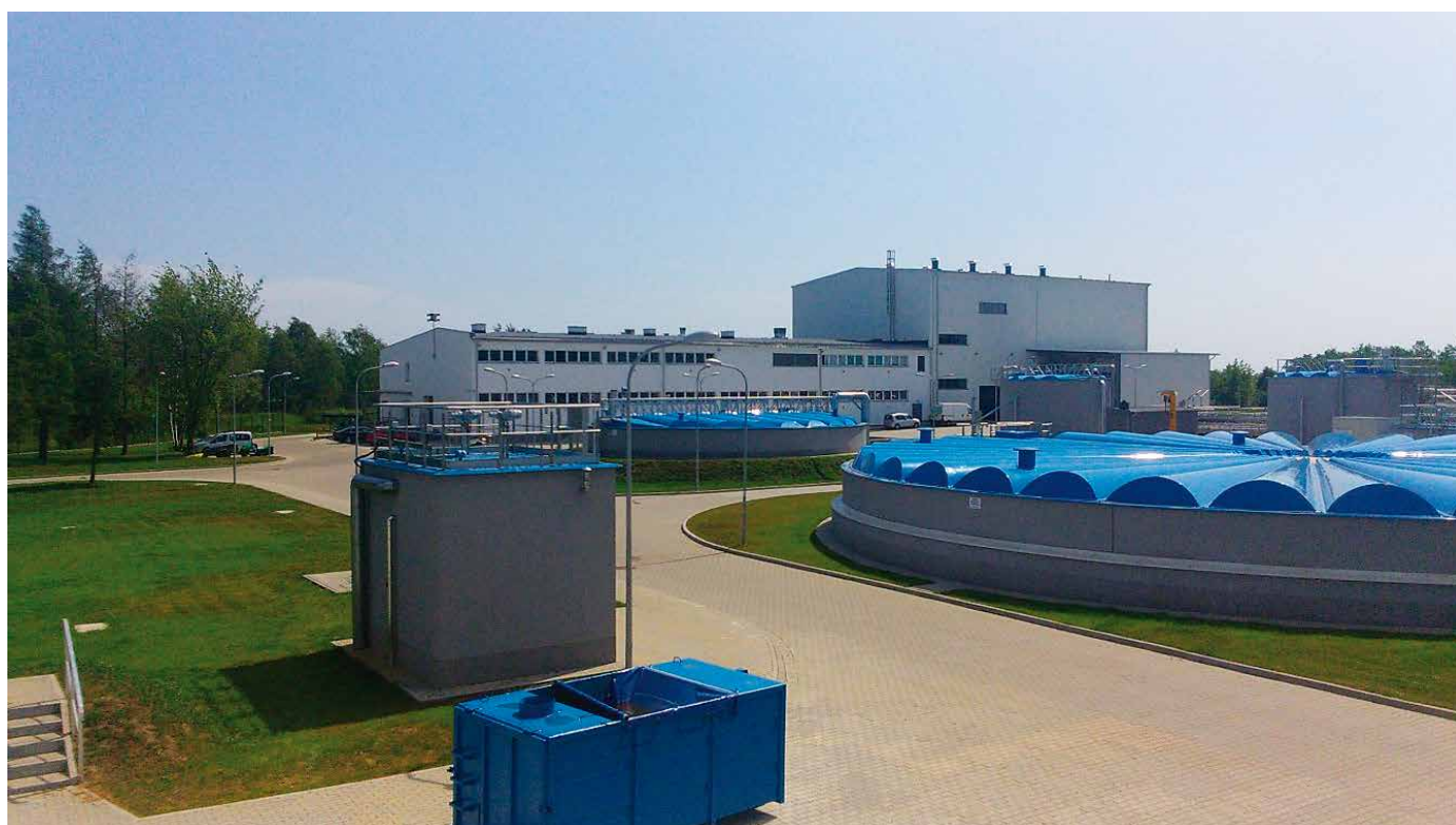
Fot. 2.12 Oczyszczalnia ścieków w Tomaszowie Mazowieckim
