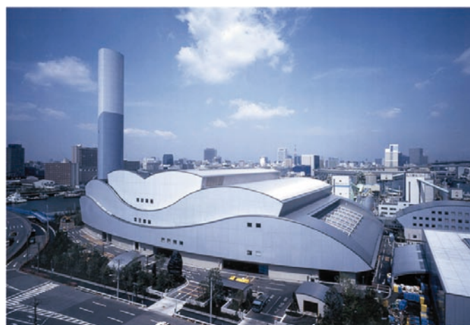
Fot. VI.2. Spalarnia odpadów w Tokio, fot. www.energiazodpadow.pl
