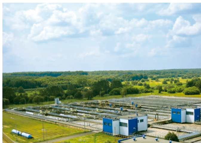
Fot. II. 1 Grupa Oczyszczalnia Ścieków w Łodzi Sp. z o.o., fot. archiwum WIOŚ
