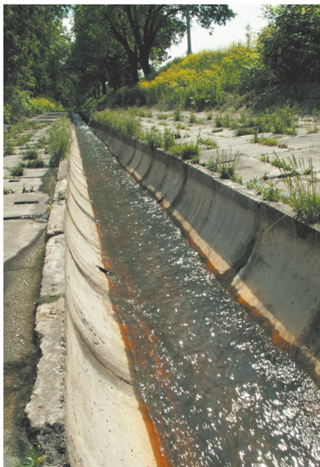
Fot. II.6 Jasień płynący skanalizowanym korytem powyżej zbiegu ulic Basenowej i Lazurowej, fot. A. Kruk
