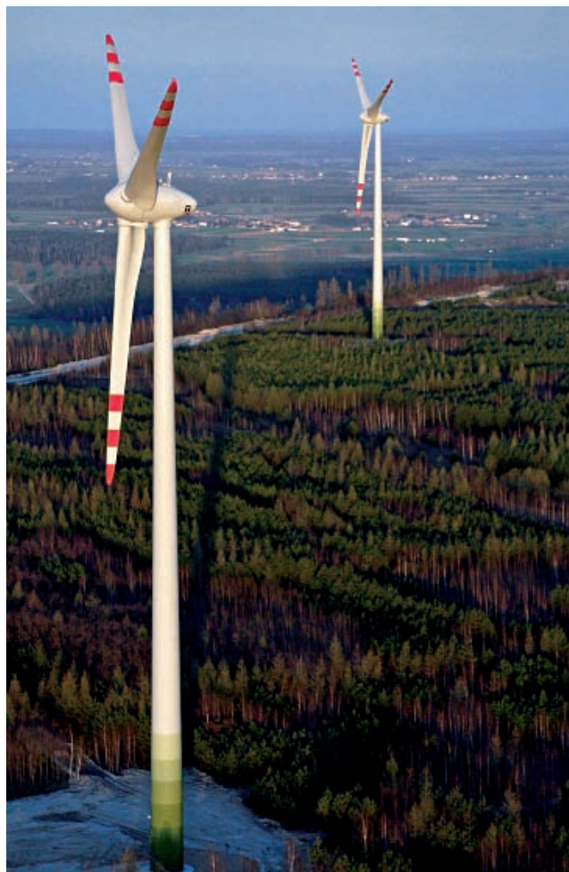
Fot.III.4 Elektrownia Wiatrowa Kamieńsk, fot. archiwum elektrowni
