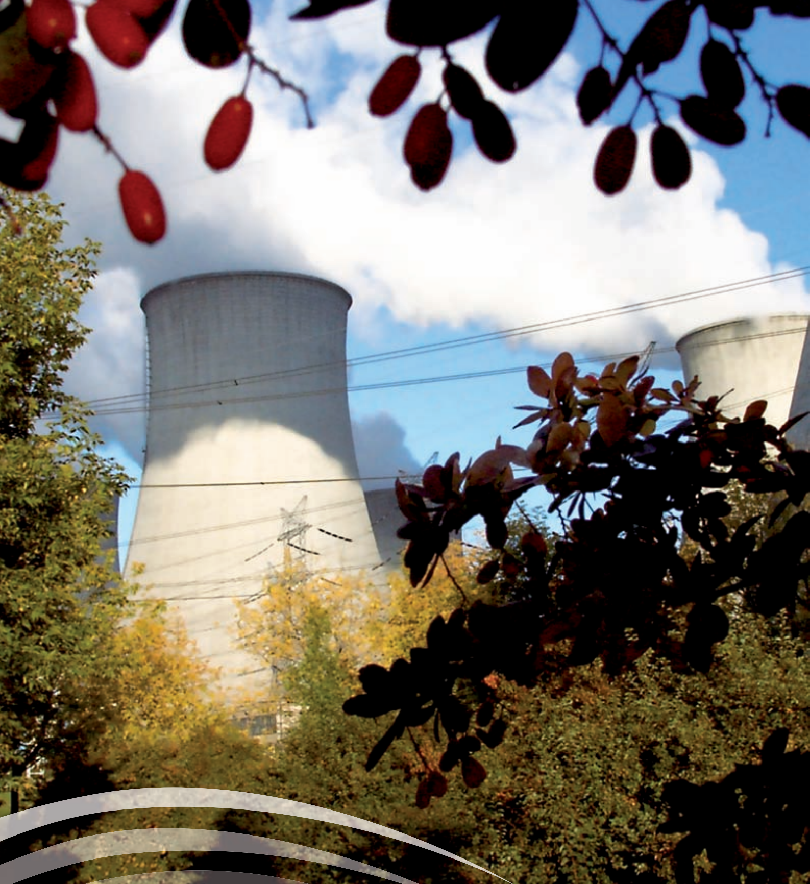
PGE Elektrownia Bełchatów, fot. archiwum elektrowni
