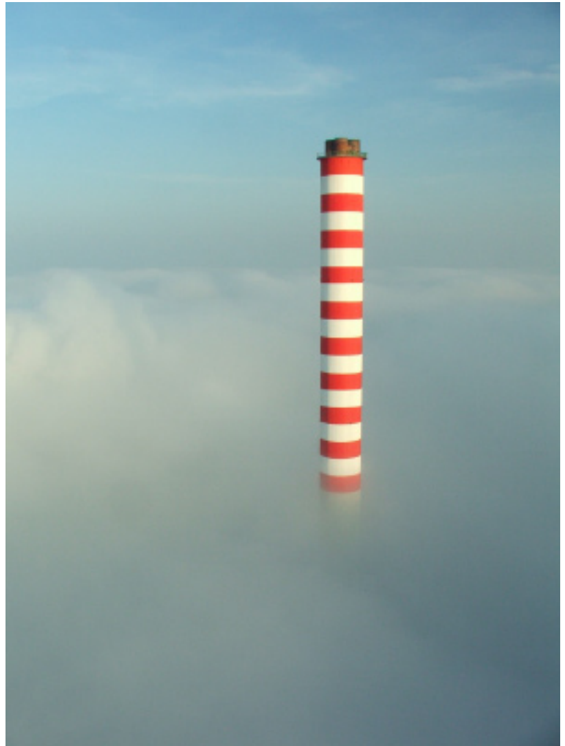
Komin Elektrociepłowni Nr 4 Dalkia Łódź S.A. powyżej poziomu chmur (fot. M. Ogródowski)
