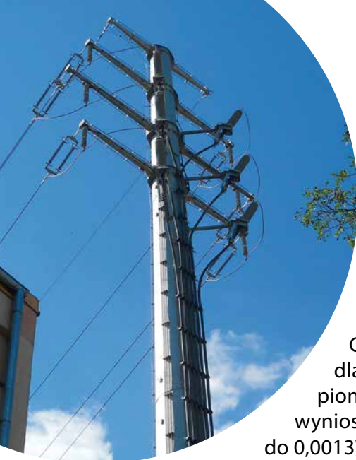
Fot. 5.1 Słup WN w Łodzi w rejonie ul. Józefa, fot. A. Wachowiec
