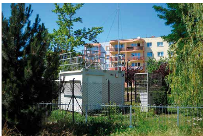
Fot. 3.1 Stacja automatyczna Łódź ul. Czernika 1-3
