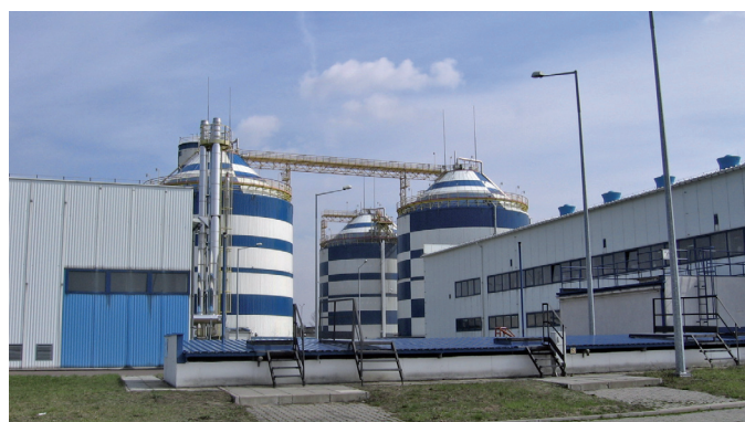
Fot. I.2 Grupowa Oczyszczalnia Ścieków w Łodzi
