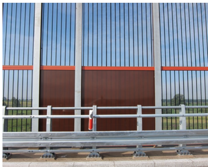
Fot. VII.6 A1 – estakada nad doliną Bzury i Pęcławki, ekrany wyposażone w zaciemnienie oraz pionowe pasy do ochrony awifauny (zdjęcie z okresu wypełniania ekranów). A. Skowron
