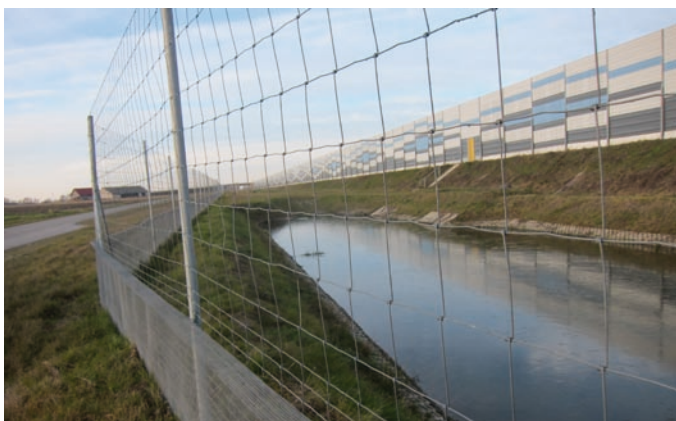
Fot. VII.9 A1 – zabezpieczenie zbiorników retencyjnych siatką dla płazów, zaopatrzoną w specjalne odgięcie, tzw. "przewieszkę" uniemożliwiającą wspinanie się po siatce. W tle ekrany akustyczne. (A. Grobelkiewicz)
