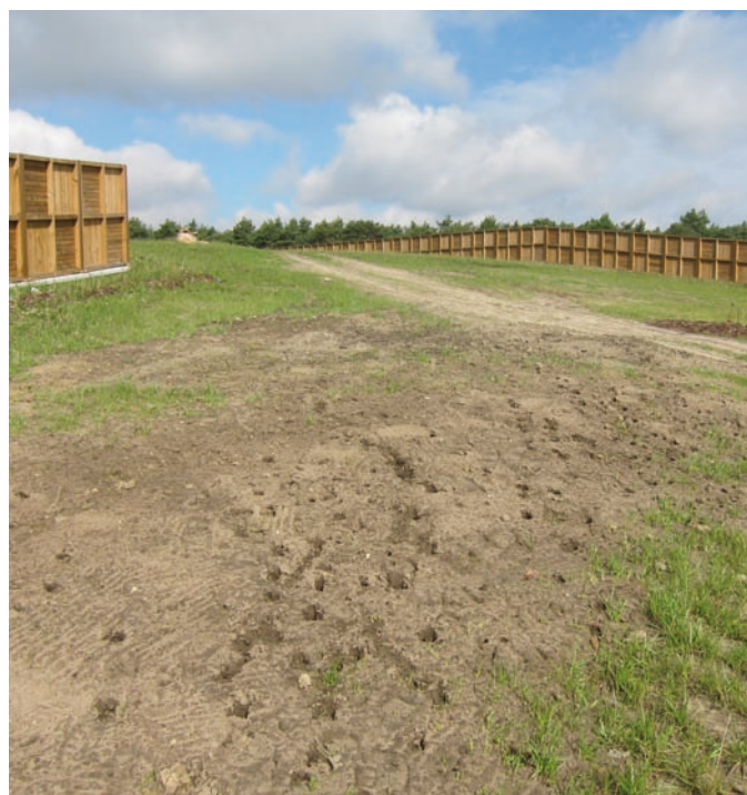
Fot. VII.7 S8 – przejście górne dla zwierząt, wyposażone w ekrany przeciwoślenniowe. Obserwowane tropy zwierząt przekraczających obiekt (sarny, dziki i jelenie). A. Skowron
