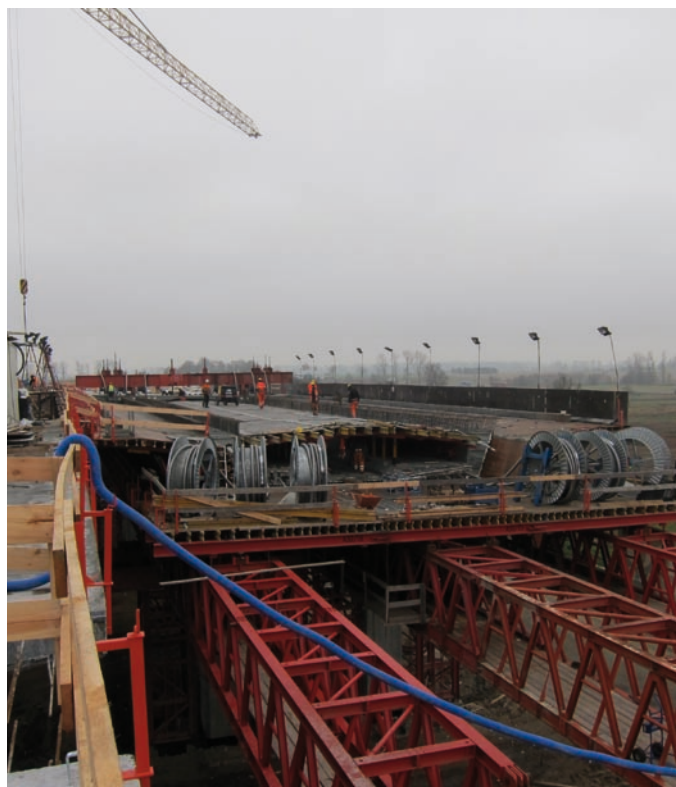
Fot. VII.3 Autostrada A1 - budowa estakady nad doliną Bzury i Pęcławki (Aleksandra Skowron)
