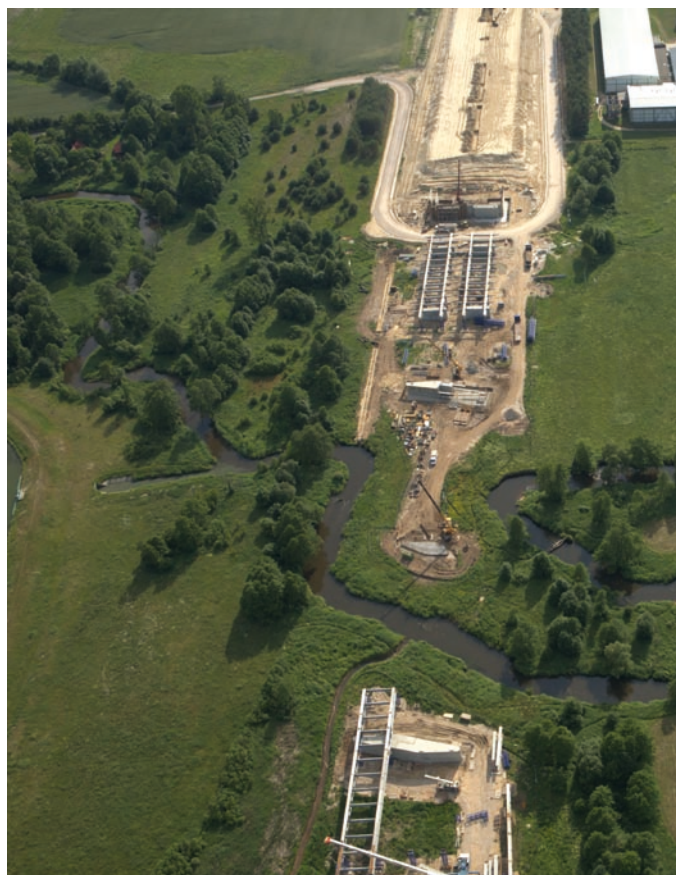
Fot. VII.4 Autostrada A2 – budowa estakady nad doliną Rawki (Michał Góra)
