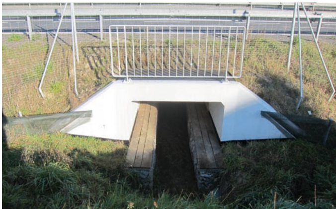
Fot. VII.8 S8 – przepust dla płazów z siatką naprowadzającą połączoną z czołem obiektu (Aleksandra Skowron)
