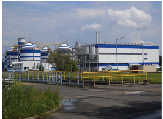
Fot. II.2 Grupa Oczyszczalnia Ścieków w Łodzi Sp. z o.o., fot. archiwum WIOŚ
