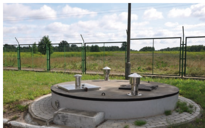
Fot. II.13 Studnia głębinowa, fot. arch. ZWIK Sp. z o.o. w Łodzi
