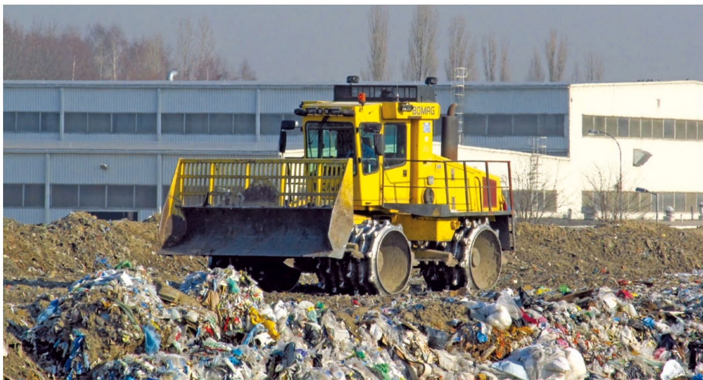
Fot. II.21 Składowisko balastu w Łodzi, ul. Zamiejska, fot. L. Kowalski
