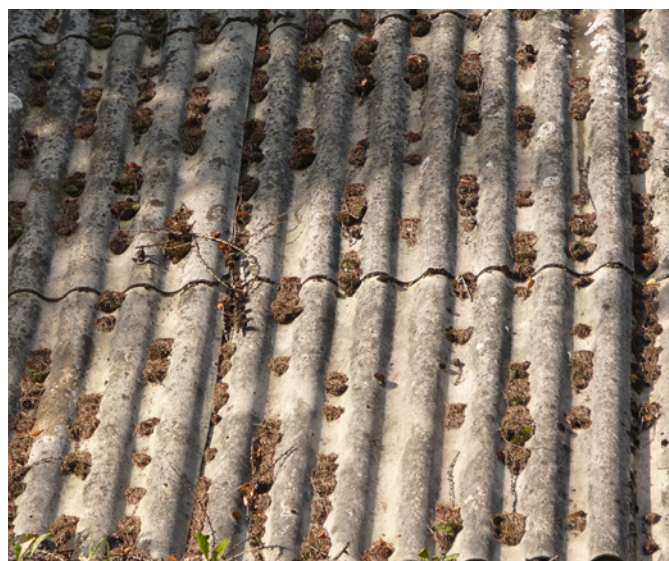
Fot. VI.1 Azbestowe pokrycie dachowe
