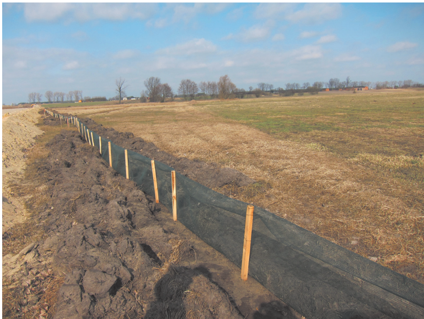
Fot. VIII.14 Płotki wygradzające teren budowy drogi, zabezpieczające przed wchodzeniem zwierząt, fot. arch. GDDKiA Łódź
