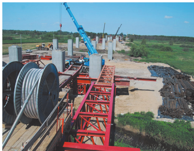
Fot. VIII.8 Plac budowy autostrady A1 fot. arch. GDDKiA Łódź
