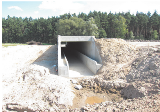
Fot. VIII.13 Budowa dolnego przejścia dla zwierząt małych pod autostradą, fot. arch. GDDKiA Łódź
