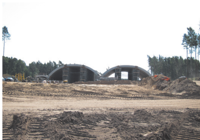
Fot. VIII.12 Budowa górnego przejścia dla zwierząt dużych na autostradzie, fot. arch. GDDKiA Łódź
