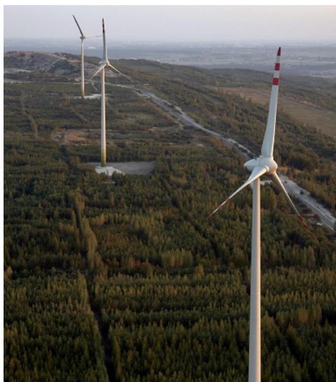
Fot. III.5 Elektrownia Wiatrowa Kamieńsk
