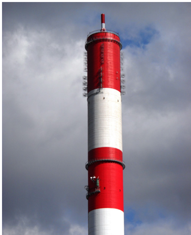
Fot. III.4 Komin EC4 Dalkia Łódź S.A., fot. A. Wachowiec
