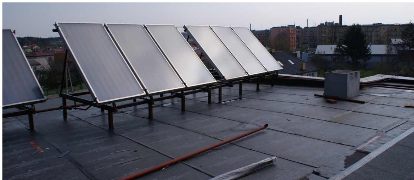
Fot. III.6 Zastosowanie odnawialnych źródeł energii – kolektorów słonecznych dla podgrzania wody w basenie Powiatowej Pływalni w Pajęcznie; fot. J. Kruk-Olczyk
