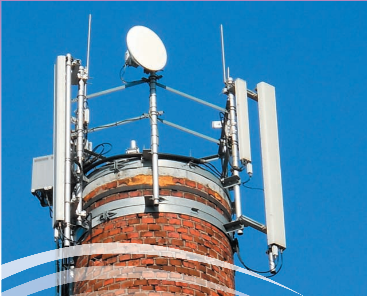
Stacja bazowa GSM przy ul. Starorudzkiej, Łódź, fot. A Wachowicz
