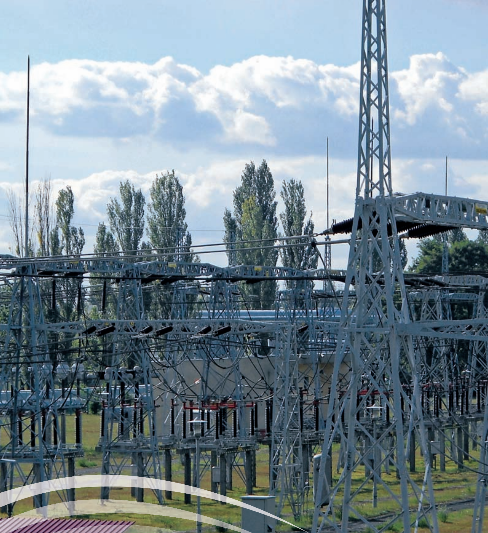
Stacja transformatorowa (Dalkia Łódź S.A. - Elektrociepłownia nr 4), fot. A. Wachowiec
